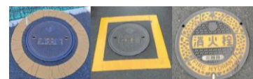
フタ塗装の剥離対策として黄色い枠で囲む場合もある
