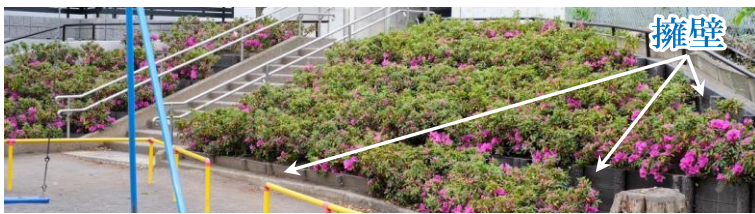
擁壁による土留施工
