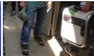
非常用発電機
