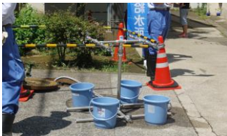
災害時給水所設備
